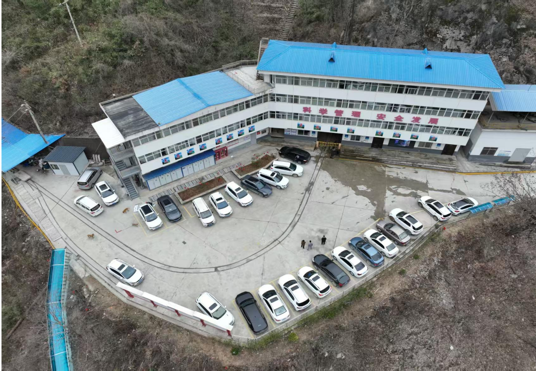
采矿区生产技术部航拍图
