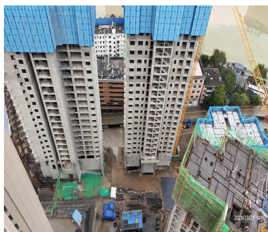
建构筑物主体施工情况
