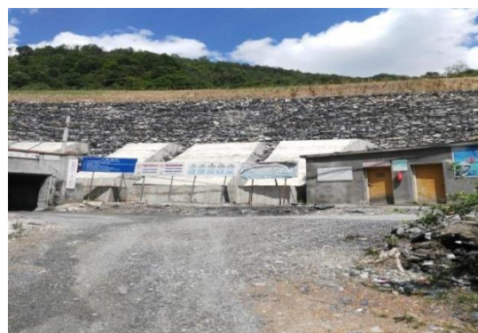
照片 2-12 渣堆挡墙
