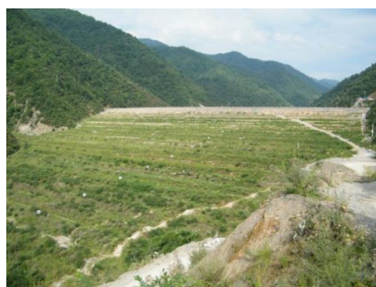
照片 2-8 拦渣墙及排洪渠
