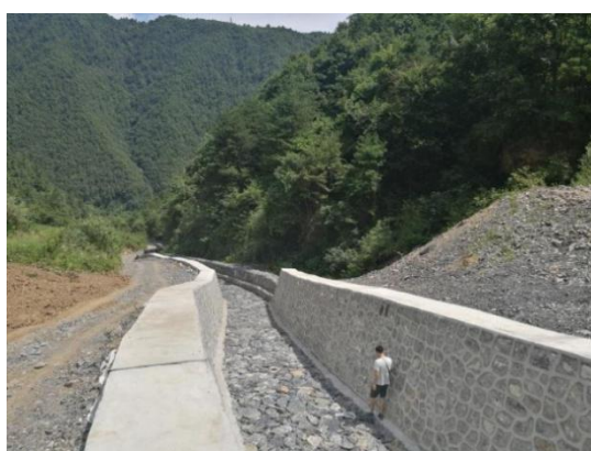
照片 2-7 拦渣墙及排洪渠
