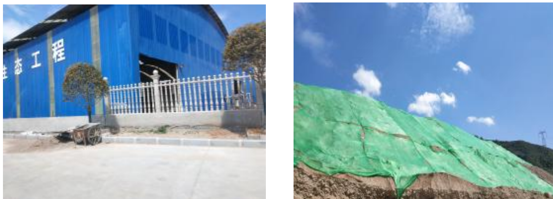
图 1-1 项目建设现状
