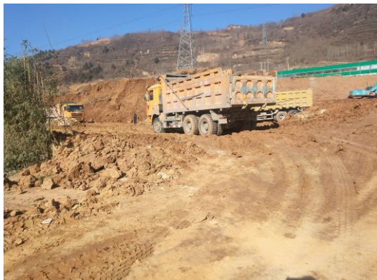
项目施工现状
