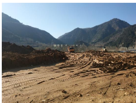
草店村场地回填现状
