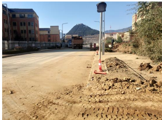
项目南侧道路现状
