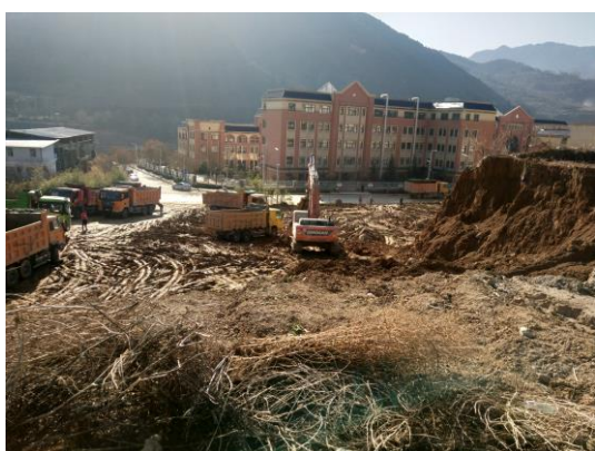
项目施工现状
