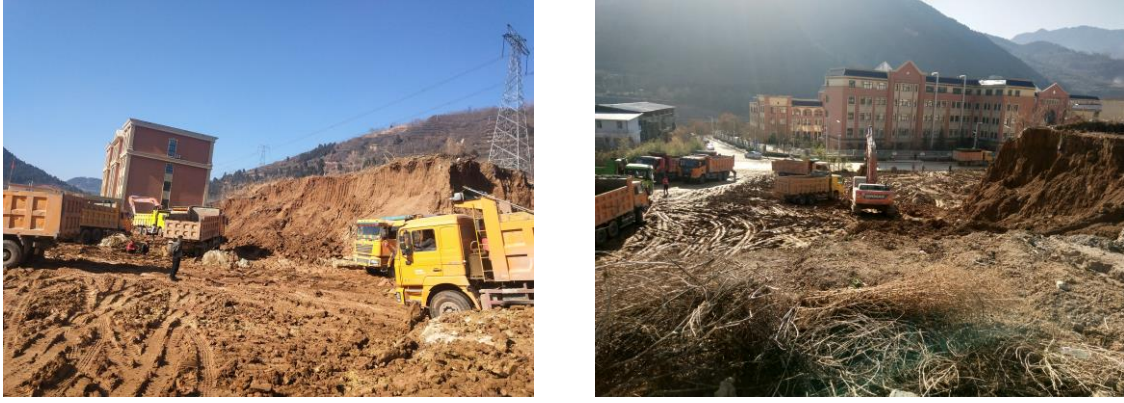
图 1-1 项目建设现状
