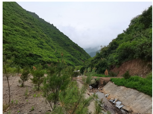
弃土场现状照片
