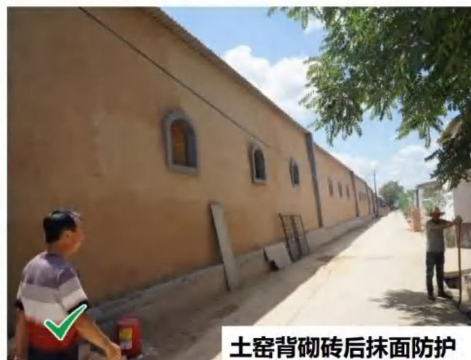
土窑背砌砖防护施工
