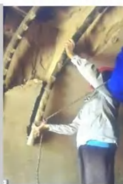
柳木拱加固土窑洞
