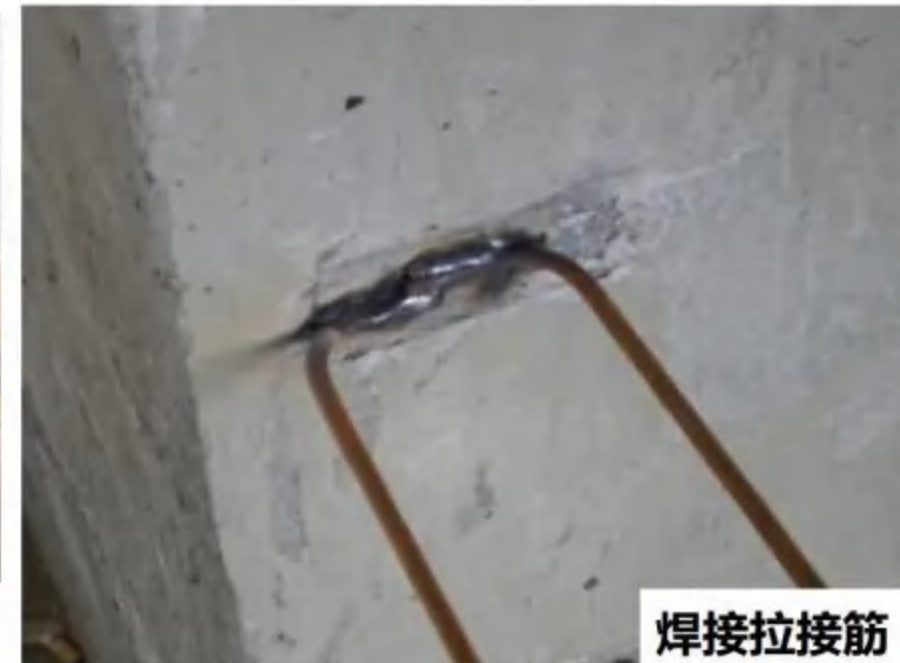
120厚墙设一根拉接筋
