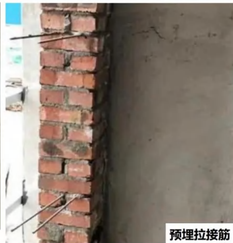
框架柱植筋拉接墙体
