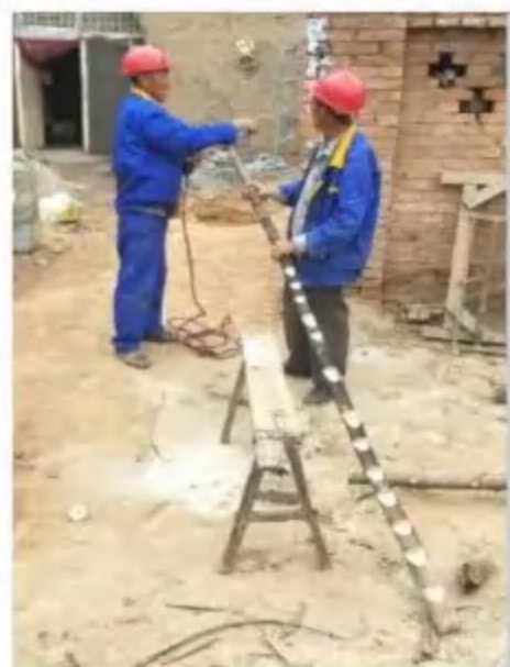
柳木拱加固土窑洞
