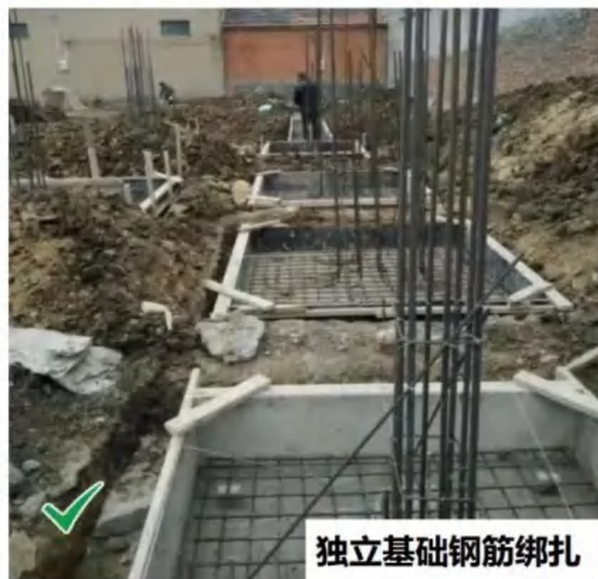
柱下混凝土独立基础
