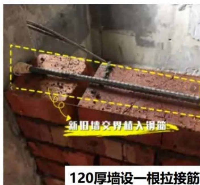
框架柱植筋拉接墙体
