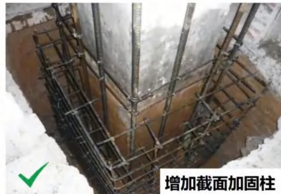
增设钢筋混凝土扶壁柱
